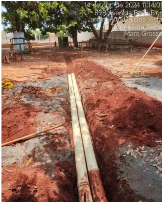
Figura 17: SEÇÃO TUBO 150MM DUPLICADA
