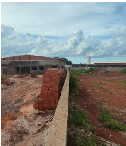
Figura 4: MURO TOMBANDO
