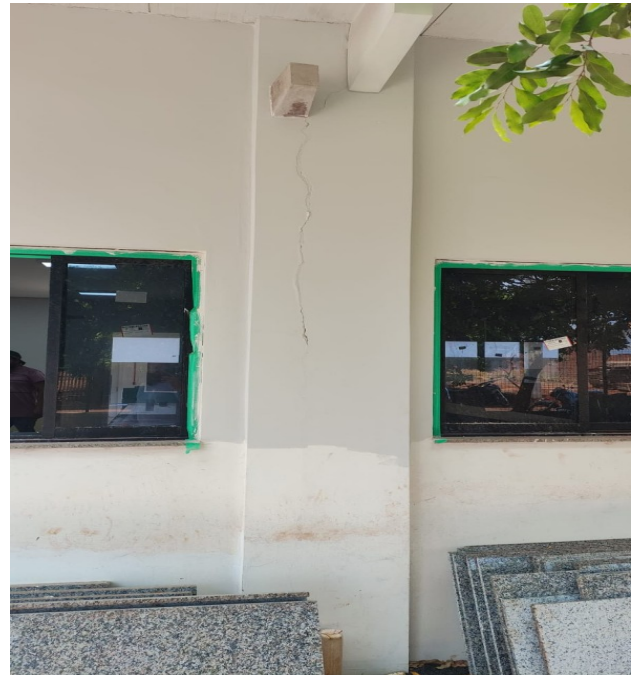
Figura 18: ACABAMENTO DE PILAR PARA LIGAÇÃO DE PRÉ-MOLDADO E PILAR DA AMPLIAÇÃO
