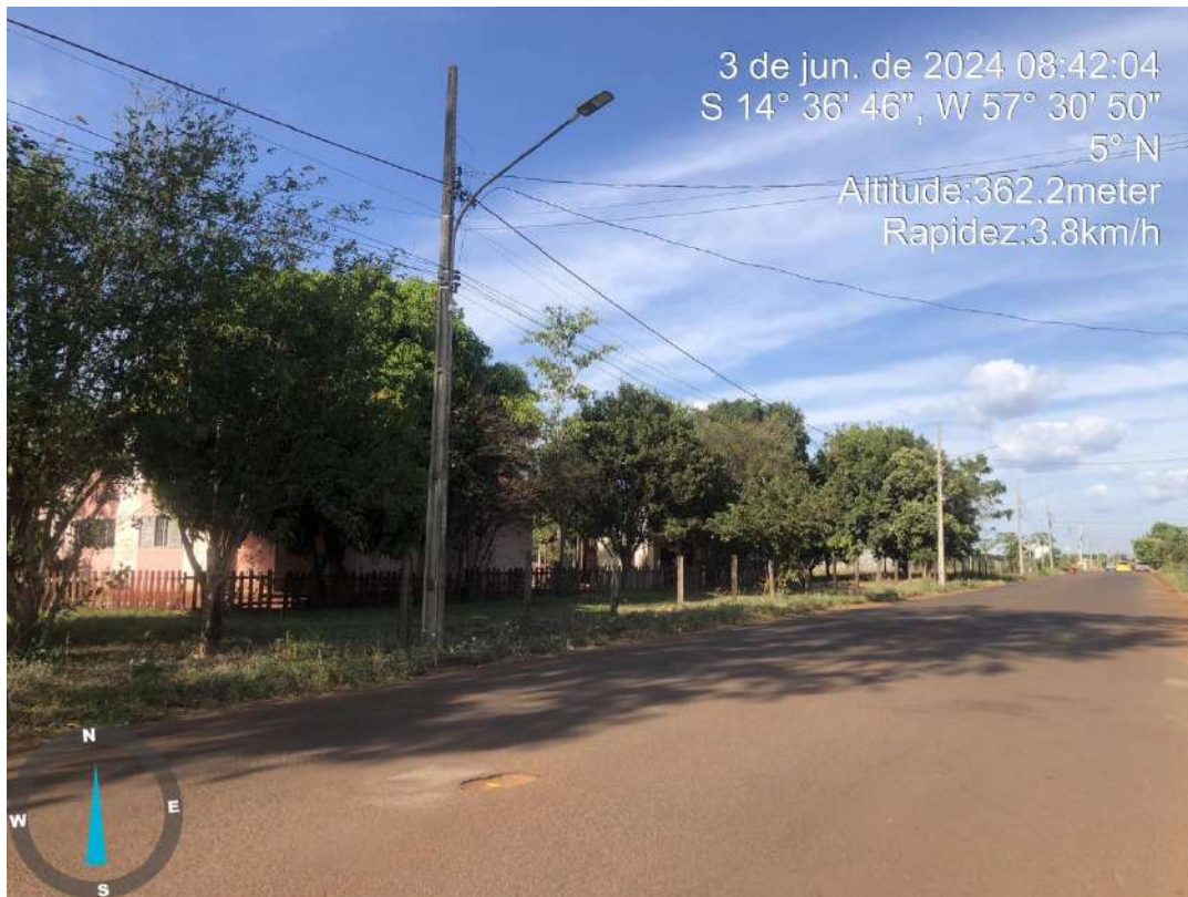
Figura 04 - Vista lateral do imóvel urbano Matrícula nº 27.157 (vista da Rua R) Fonte: Departamento de Estudos e Projetos/Seplan
