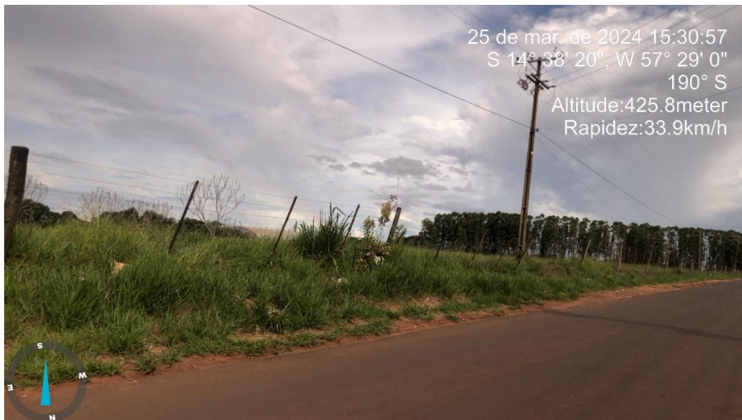
Figura 03 - Vista do imóvel urbano Matrícula nº 16.792 Fonte: Departamento de Estudos e Projetos/Seplan
