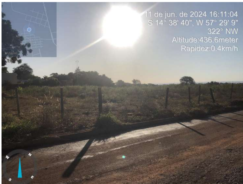
Figura 08 - Vista da Área Remanescente 02 (a desmembrar) parte do imóvel urbano Matrícula nº 33.741 Fonte: Departamento de Estudos e Projetos/Seplan
