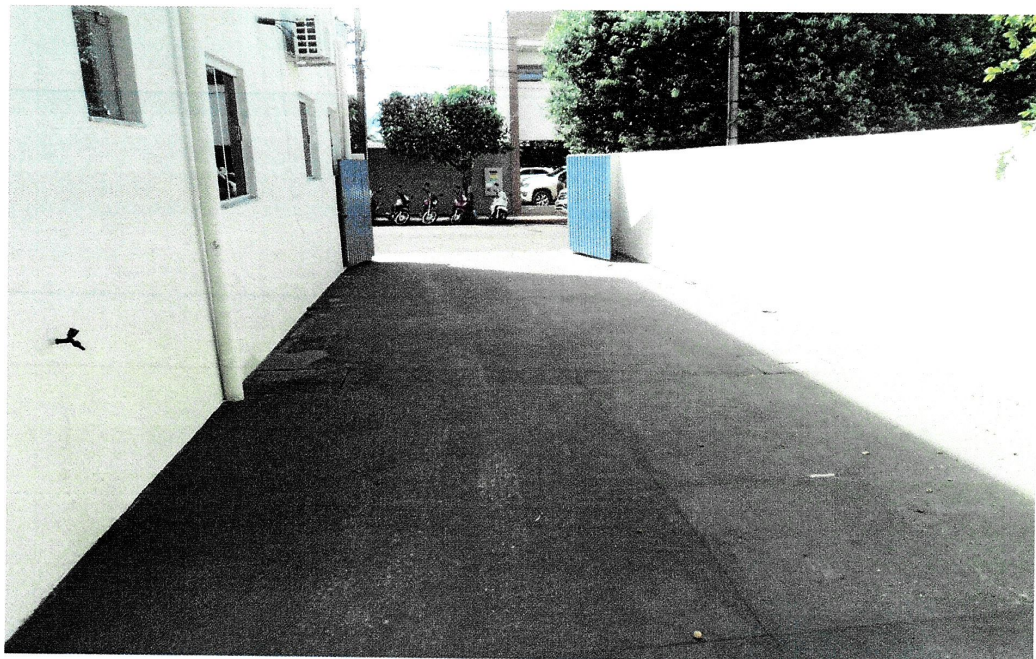
Foto do portão reformado com piso reformado
