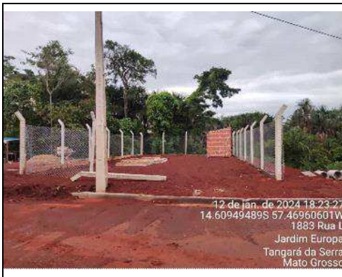
Foto 25- Estação Elevatória de Esgoto
