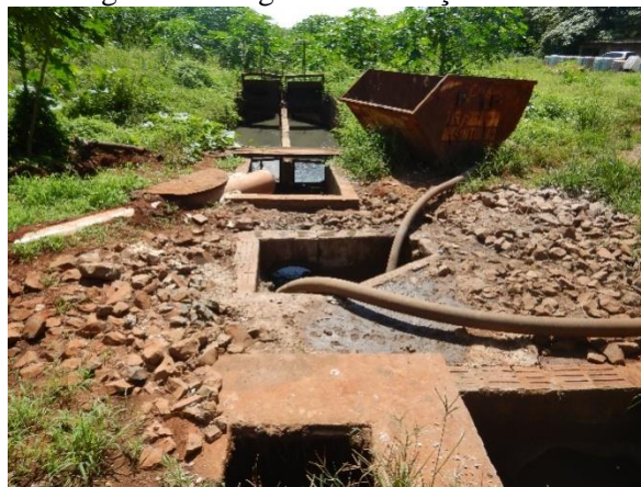
Figura 358. Contêiner de resíduos de limpeza da grade e mangueiras de lançamento
