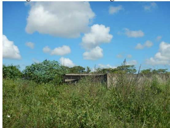
Figura 233. Leito de secagem de lodo.
