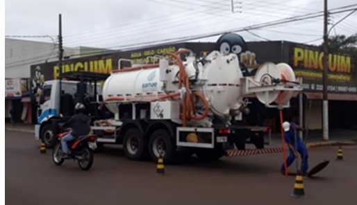
Figura 217. Limpeza da rede de esgoto na Av. Brasil.
