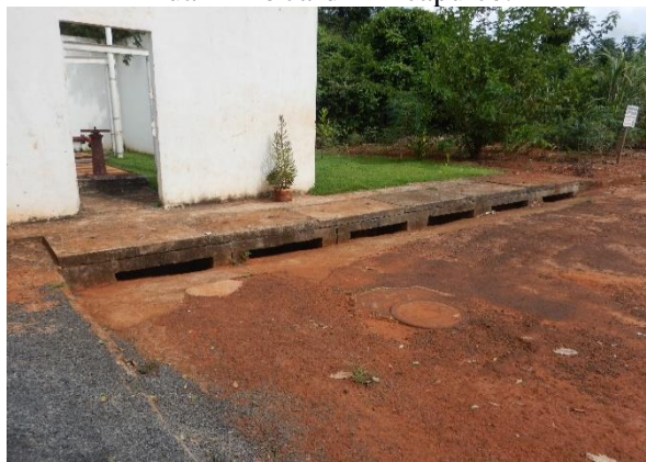
Figura 384. Bocas de lobo próximo à Rua 42 no Jardim Acapulco.
