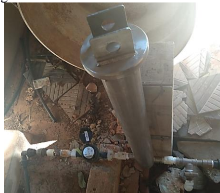
Figura 442. Clorador de contato do distrito.
