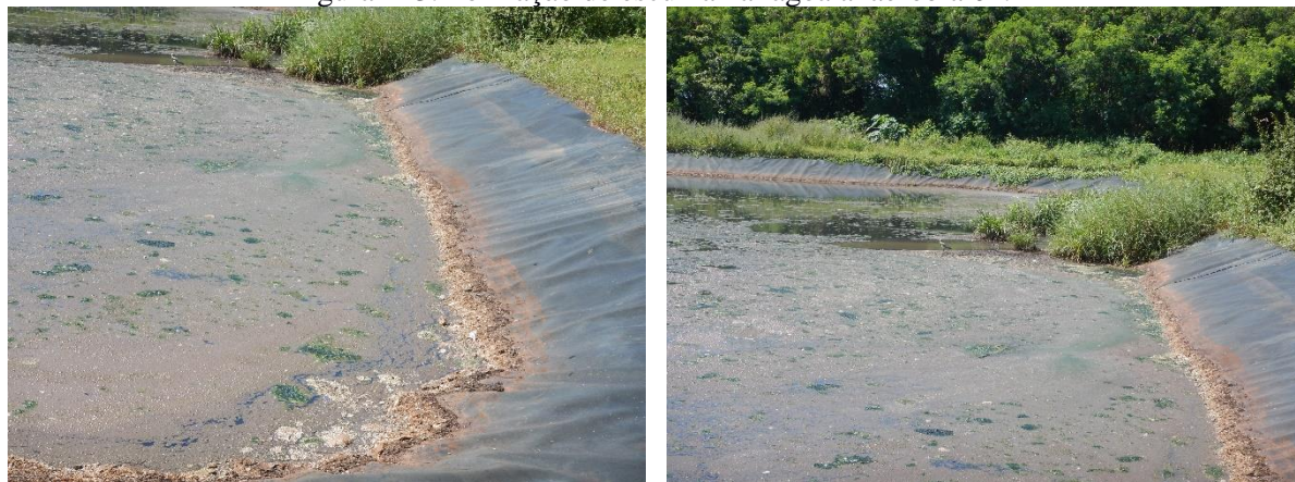
Figura 243. Formação de espuma na lagoa anaeróbia 02.
