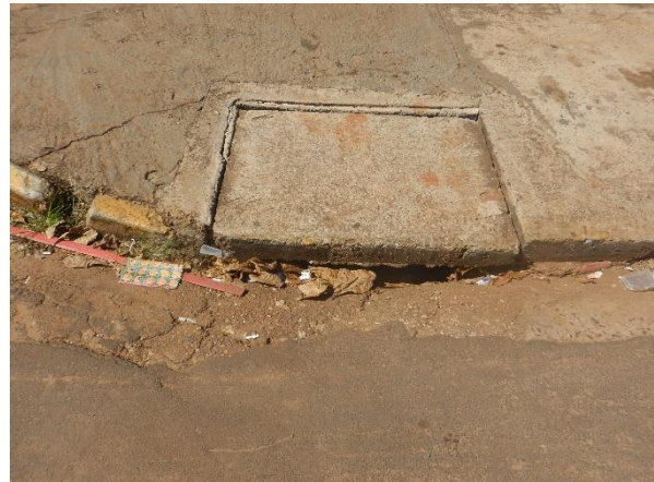
Figura 400. Boca de lobo com acúmulo de resíduos sólidos.
