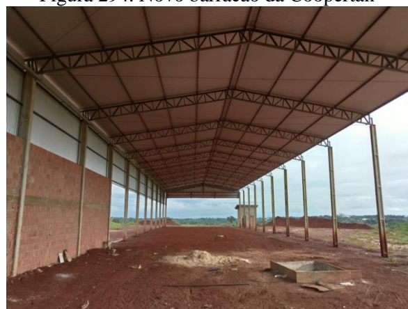
Figura 294. Novo barracão da Coopertan
