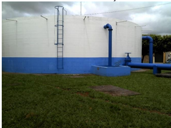
Figura 200. Reservatório apoiado em concreto armado do centro de reservação Vila Alta
