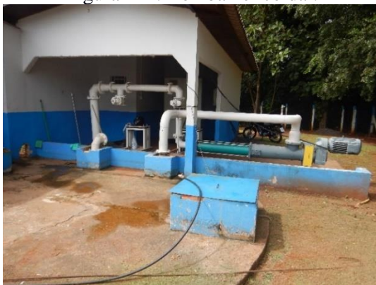
Figura 224. Bomba helicoidal.
