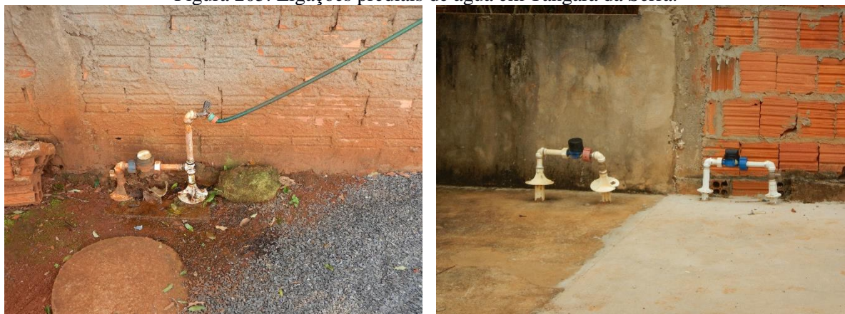
Figura 205. Ligações prediais de água em Tangará da Serra.
