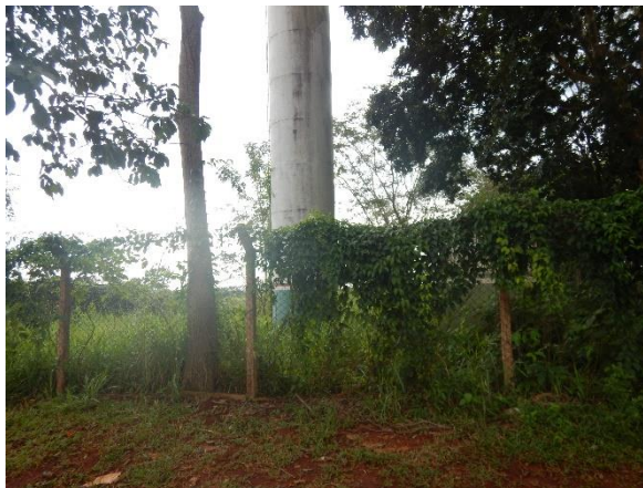
Figura 171. Reservatório desativado no Alto da Boa Vista.
