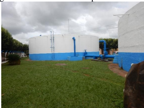
Figura 195. Reservatório Apoiado Vila Alta.
