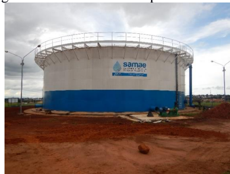
Figura 196. Reservatório Apoiado Valência.
