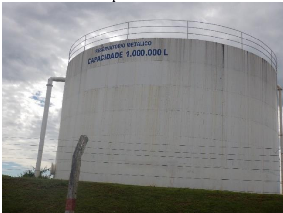
Figura 202. Reservatório apoiado de estrutura metálica São Luiz.
