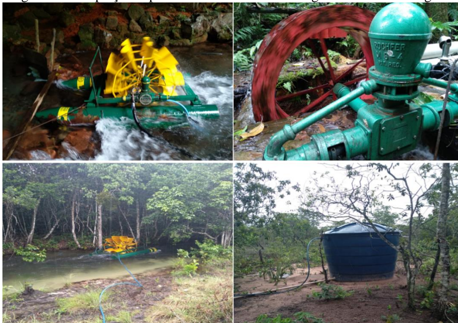
Figura 471. Captação superficial e reservatórios de água nas aldeias indígenas
