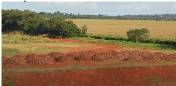
Figura 306. Material de recobrimento de resíduos
