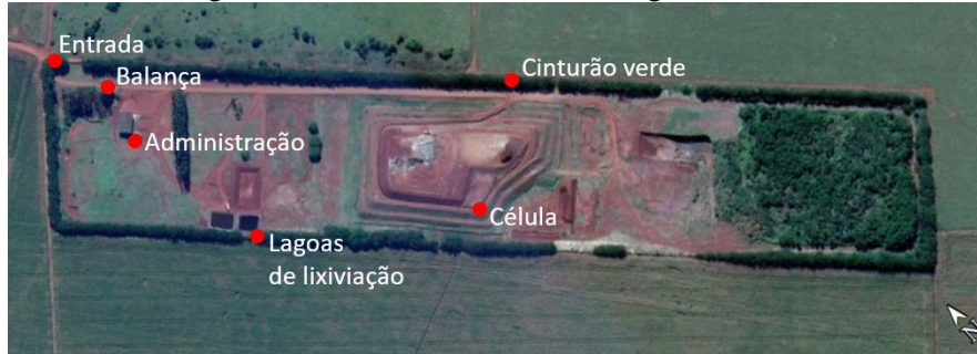
Figura 300. Aterro Sanitário de Tangará da Serra
