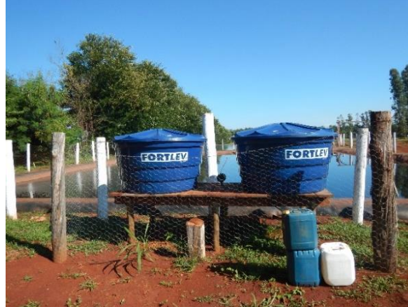
Figura 320. Caixas de armazenamento do aditivo microbiológico eficaz
