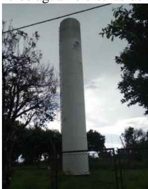
Figura 448. Reservatório de água no distrito de São Joaquim do Boche.
