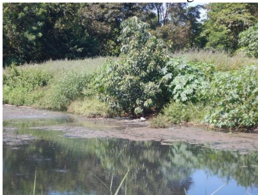
Figura 244. Plantas na entrada da lagoa anaeróbia 01.
