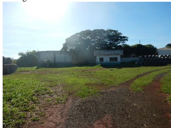
Figura 204. Reservatório Vila Esmeralda.
