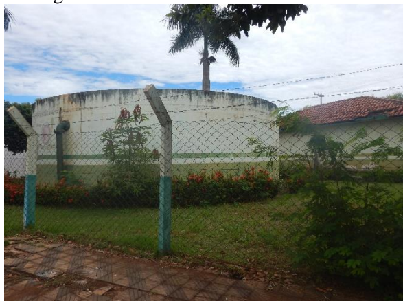
Figura 203. Reservatório Cohab Tarumã.
