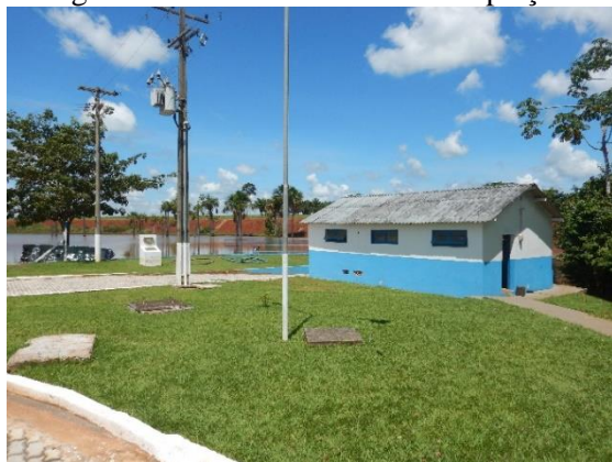
Figura 177. Casa de bombas da captação.
