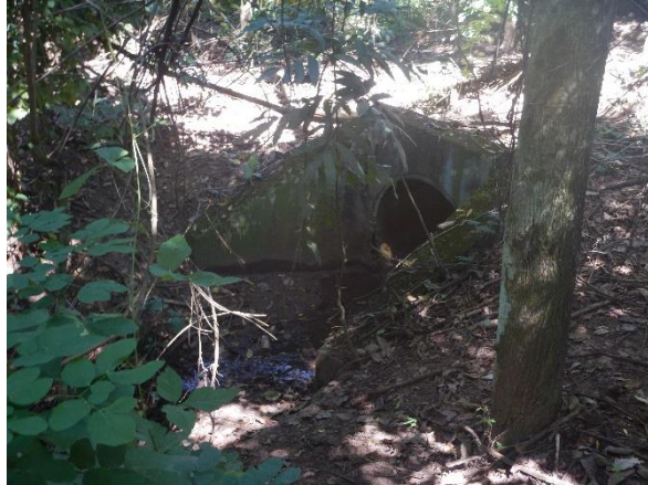
Figura 375. Ponto de lançamento sem dissipador de energia.
