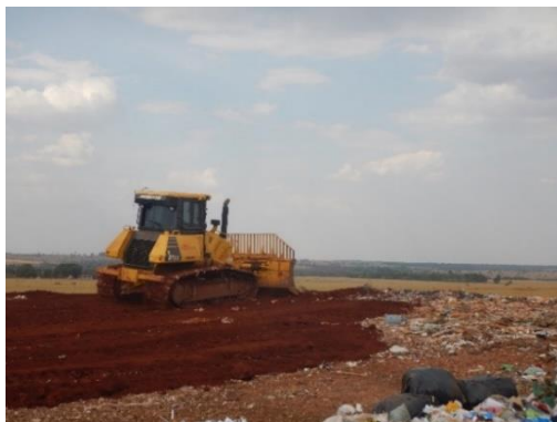
Figura 335. Recobrimento dos resíduos com argila
