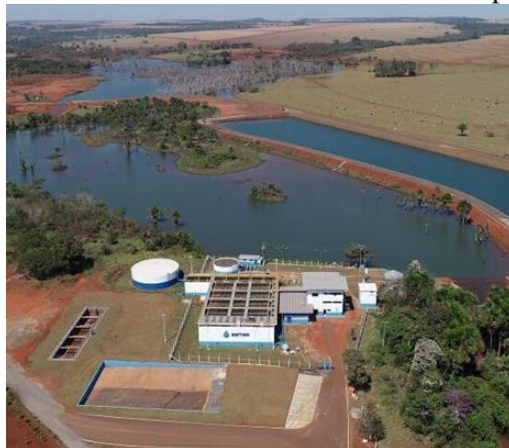
Figura 120. Vista aérea das APP's do sistema de captação do SAMAE.
