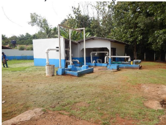
Figura 221. Estação Elevatória de Esgoto - Jardim do Sul.
