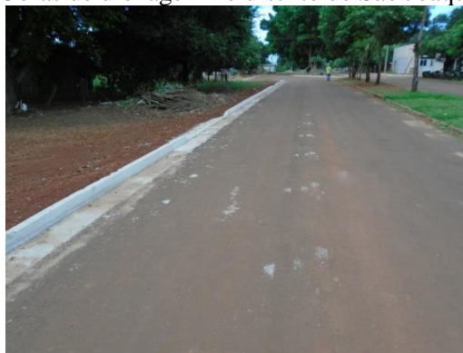
Figura 479. Obras de drenagem no distrito de São Joaquim do Boche.
