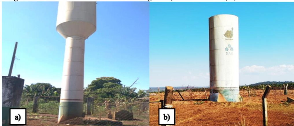
Figura 459. Reservatórios da Gleba Triângulo. a) Reservatório 1; b) Reservatório 2.
