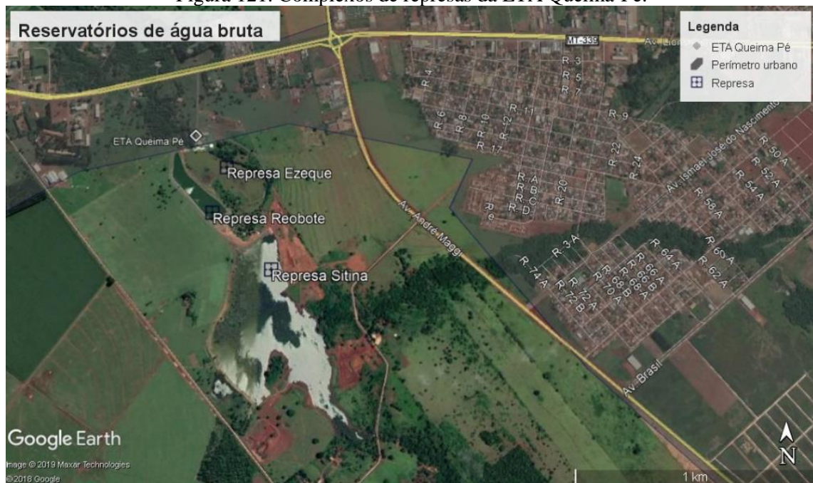
Figura 121. Complexos de represas da ETA Queima-Pé.
