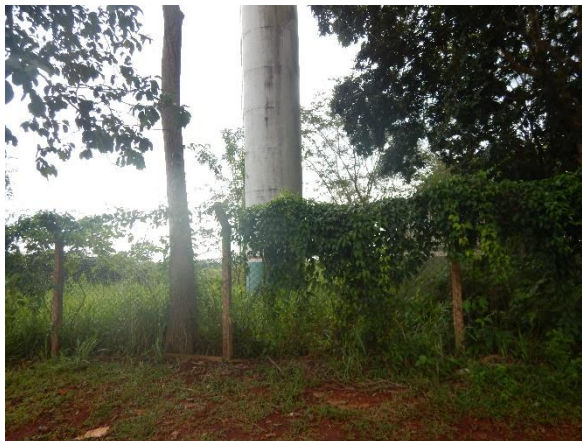
Figura 171. Reservatório desativado no Alto da Boa Vista.
