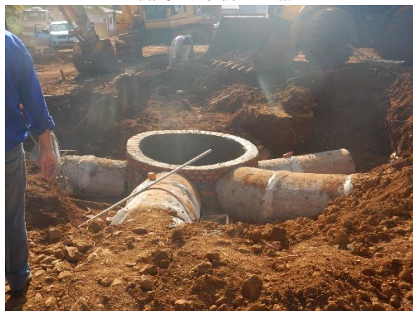
Figura 389. Execução da caixa de passagem na Rua Olívio de Lima.
