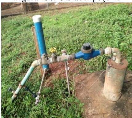
Figura 450. Clorador poço 1.
