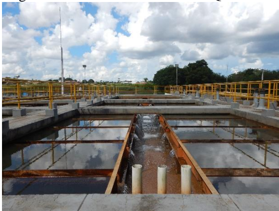
Figura 186. Decantadores da ETA Queima-Pé.
