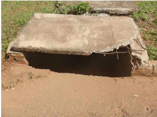
Figura 399. a) Boa de lobo com tampa quebrada; b) Boca de lobo quebrada apresentando riscos de acidente à população.
