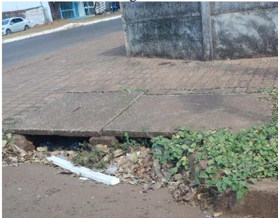
Figura 400. Boca de lobo com acúmulo de resíduos sólidos.
