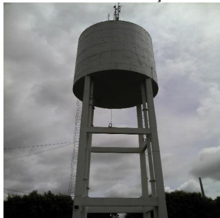
Figura 201. Reservatório elevado em concreto armado do centro de reservação Vila Alta.
