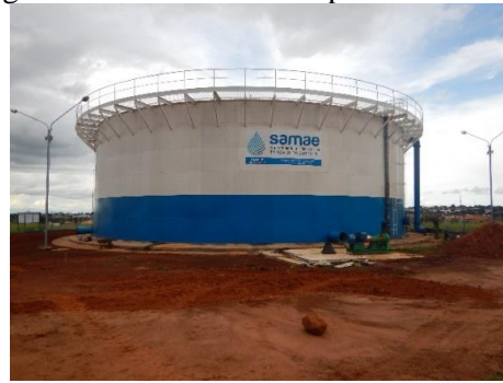
Figura 196. Reservatório Apoiado Valência.
