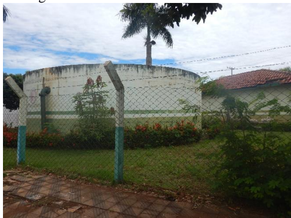
Figura 203. Reservatório Cohab Tarumã.
