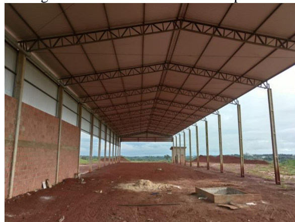
Figura 294. Novo barracão da Coopertan
