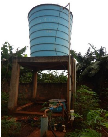
Figura 172. Reservatório elevado e poço da comunidade São José.
