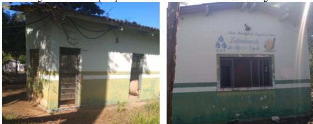
Figura 438. Edificações próximas ao reservatório do distrito de Progresso.
