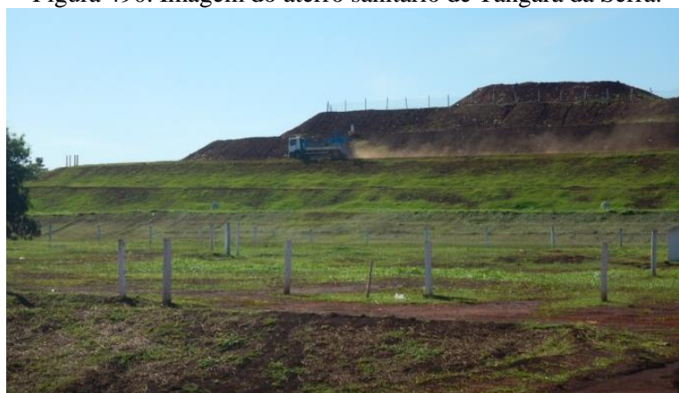
Figura 490. Imagem do aterro sanitário de Tangará da Serra.
