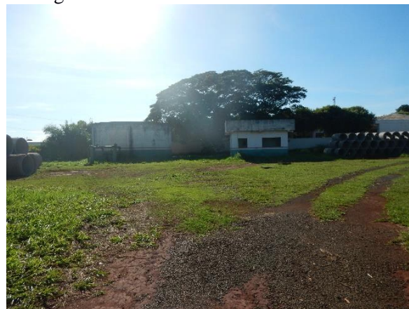
Figura 204. Reservatório Vila Esmeralda.
