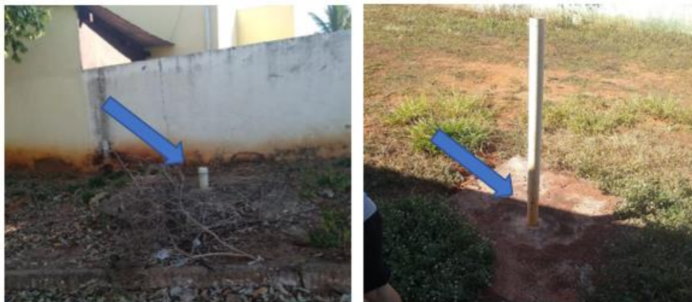
Figura 472. Fossa rudimentar no distrito de Progresso.
