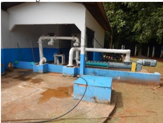
Figura 224. Bomba helicoidal.
