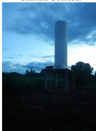
Figura 175. Reservatório metálico da Chácara Uberaba.
