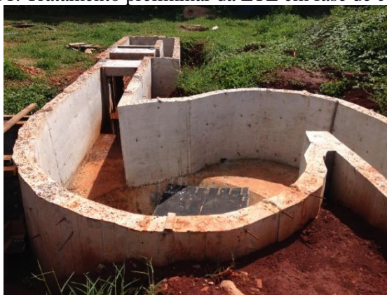
Figura 231. Tratamento preliminar da ETE em fase de construção.
