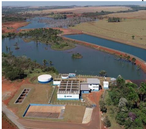
Figura 120. Vista aérea das APP's do sistema de captação do SAMAE.
