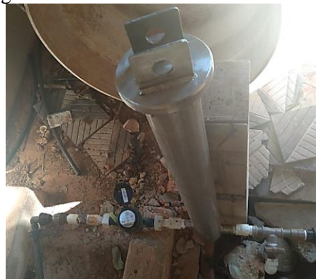
Figura 442. Clorador de contato do distrito.
