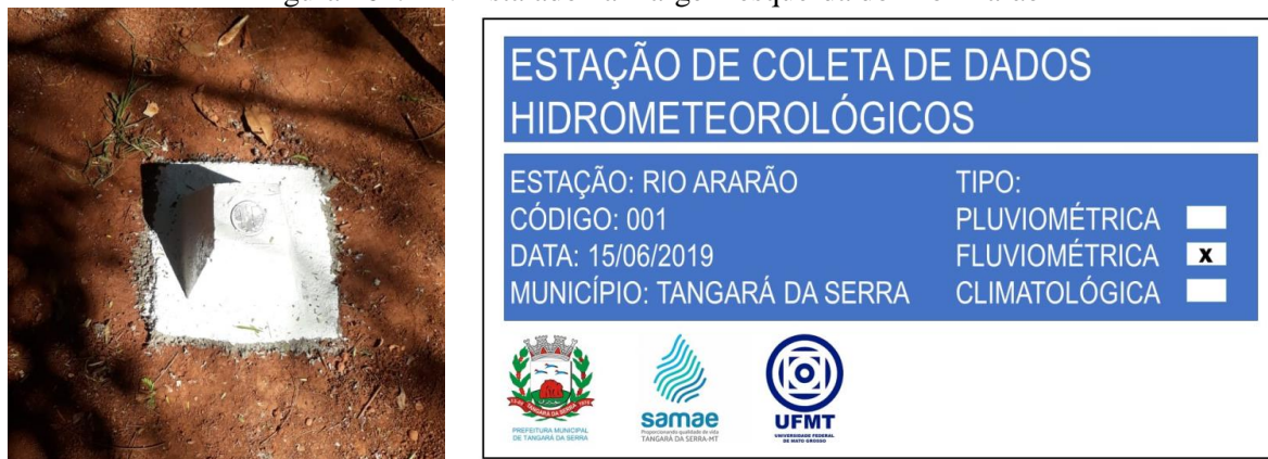
Figura 264. RN instalado na margem esquerda do Rio Ararão
