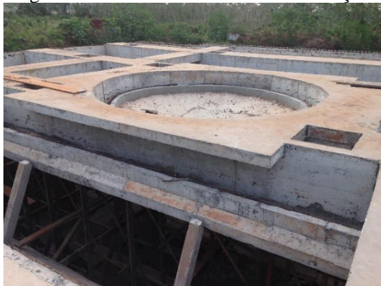
Figura 232. Reator anaeróbio em construção.
