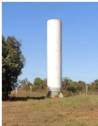
Figura 465. Reservatório ETA da Agrovila 2.
