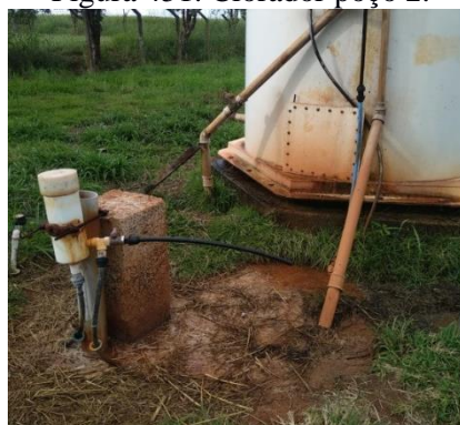
Figura 451. Clorador poço 2.
