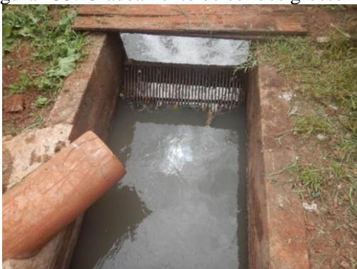
Figura 235. Gradeamento de sólidos grosseiros.
