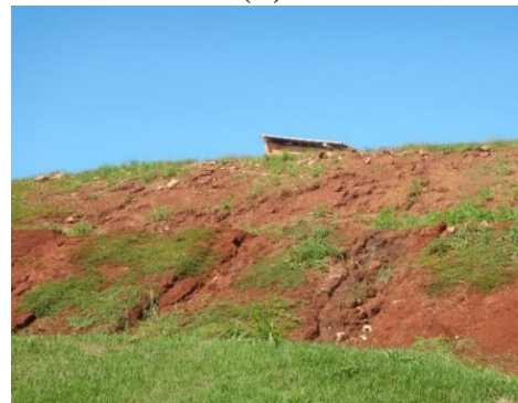
Figura 338. (A) Vista da cobertura da célula, (B) Fendas nos taludes.
