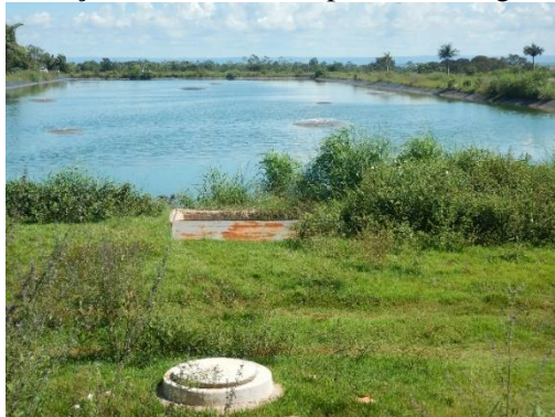
Figura 247. Formação de bolhas na superfície da lagoa facultativa 01.
