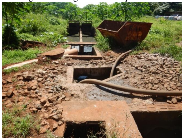
Figura 358. Contêiner de resíduos de limpeza da grade e mangueiras de lançamento
