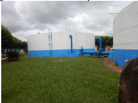
Figura 195. Reservatório Apoiado Vila Alta.
