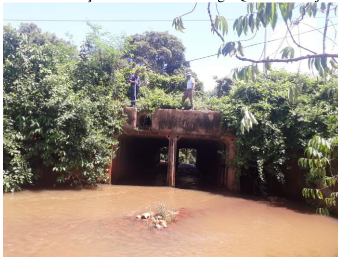
Figura 136. Determinação de vazão no Córrego Queima-Pé a jusante ETA.
