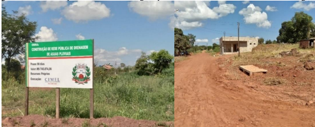
Figura 476. Construção de rede de drenagem pluvial e boca de lobo no distrito de Progresso.
