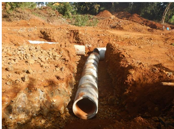
Figura 388. Execução da galeria pluvial na Rua Olívio de Lima.
