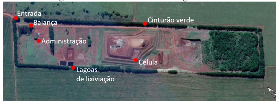
Figura 300. Aterro Sanitário de Tangará da Serra
