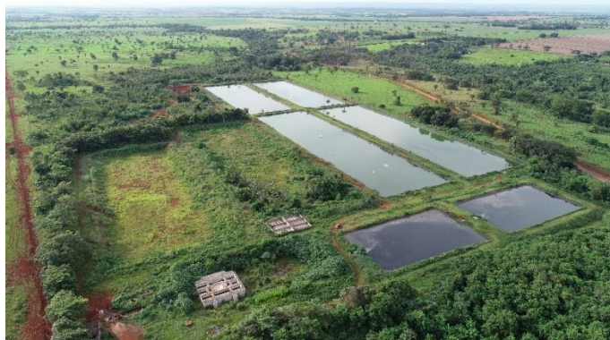
Figura 230. Estação de Tratamento de Esgoto - ETE Ararão.
