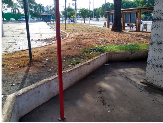
Figura 1: Mureta de elevação de canteiro
