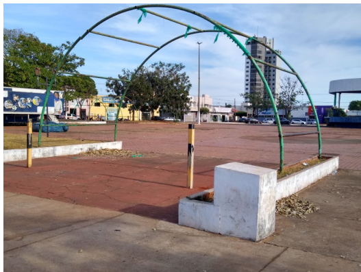
Figura 3: Arco de entrada frontal
