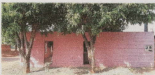
Unidade 02 - frente (Rua E)
