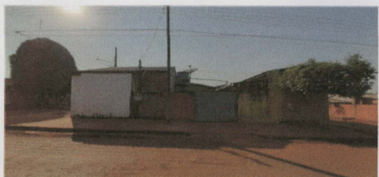
Unidade 01 - lateral e Unidade 02
