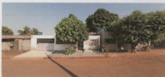
Unidade 01 - lateral e Unidade 02 - frente
